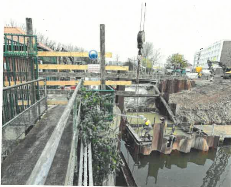
Les travaux en cours préparent l'installation d'une vanne qui permettra d'évacuer les eaux du canal de Furnes vers la mer. PHOTOS SÉBASTIEN JARRY
