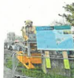
Le chantier est un des volets du projet transfrontalier Mageteaux.
