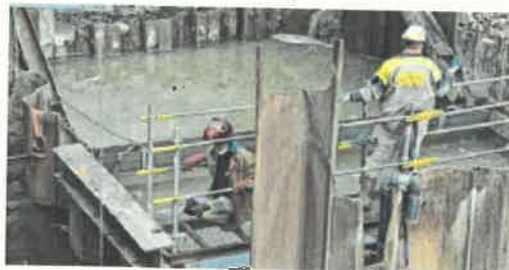
Les travaux en cours préparent l'installation d'une vanne qui permettra d'évacuer les eaux du canal de Furnes vers la mer. PHOTOS SÉBASTIEN JARRY
